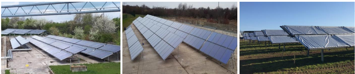
Abbildung 14: Solarthermie-Anlagen in Erfurt und Mühlhausen 77
