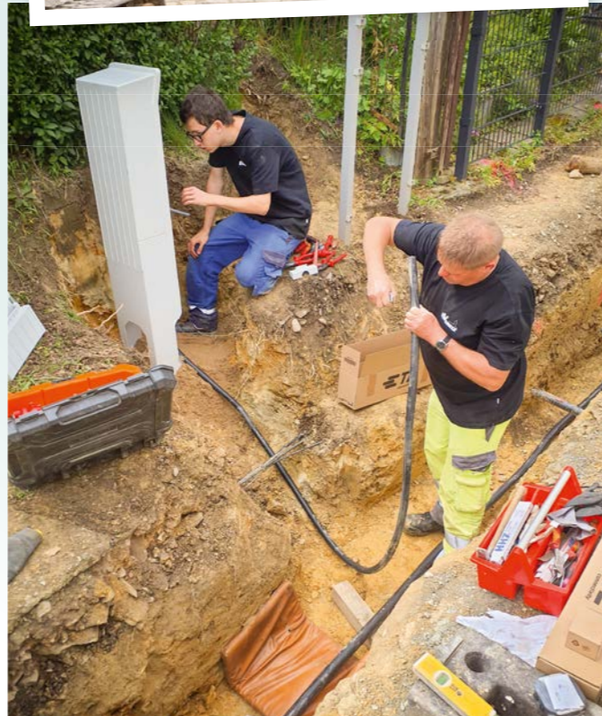
Ein modernes Stromnetz ist die Voraussetzung für eine sichere Energieversorgung: Hier werden von den Mitarbeitern der EV Greiz neue Stromkabel und Verteilerkästen im Hasental installiert.
